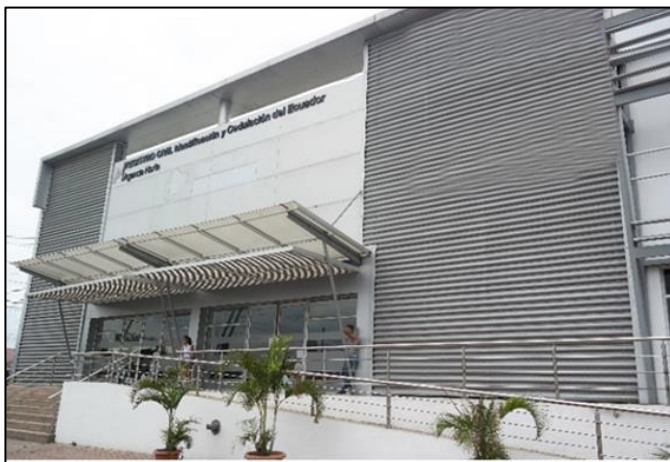
Dirección: Vía Daule 11.5 Km, junto al Parque California Teléfono: 043712030 ext. 12300
